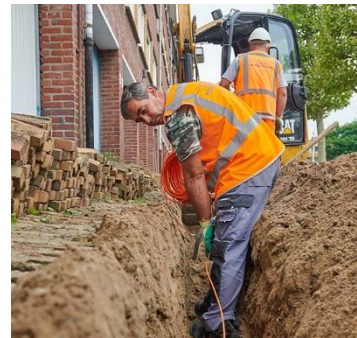
Volledig ingegraven kabel
